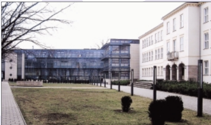
Oberstufenzentrum I in Cottbus, Ansicht des sanierten Alt- und des Neubaus
