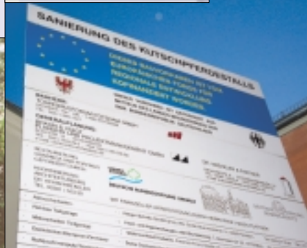
Sanierung des Kutschpferdestalls in Potsdam, gefördert aus EFRE-Mitteln
